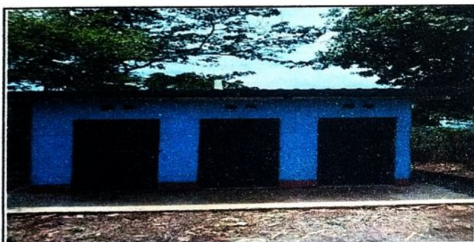
Foto 5: SUSTITUCION DE: LETRINA, PUERTAS, LAMINAS Y PINTURA
